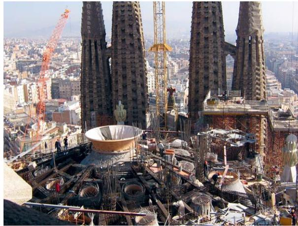
**Fig. 1.** Example of a complex formwork – La Sagrada Família, Antoni Gaudí, Barcelona.
